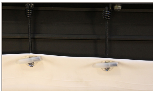
Tension de la toile sur oeillets à l'arrière du cadre
